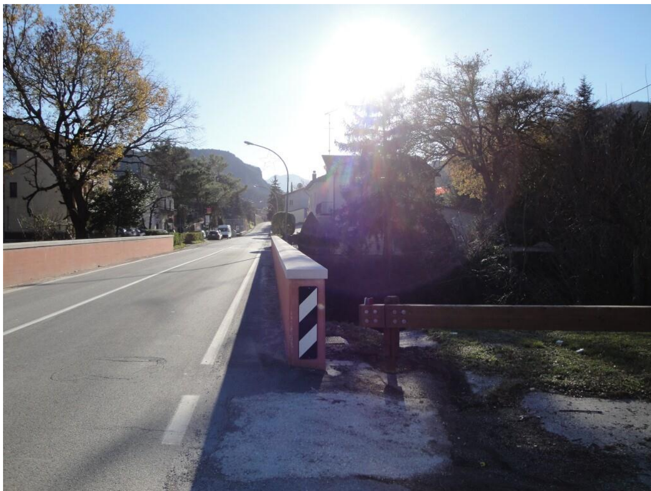
Primo ponte stradale di Bellisio
