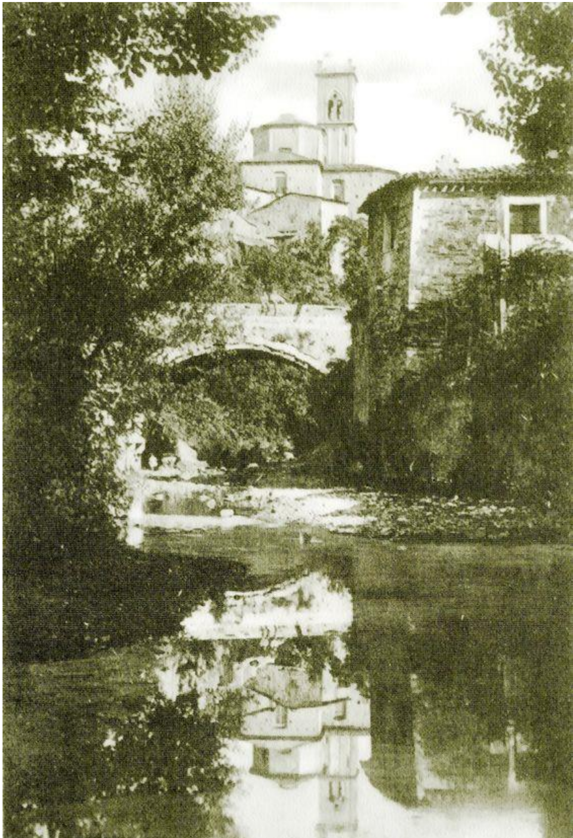
Pergola Ponte delle Birarelle
