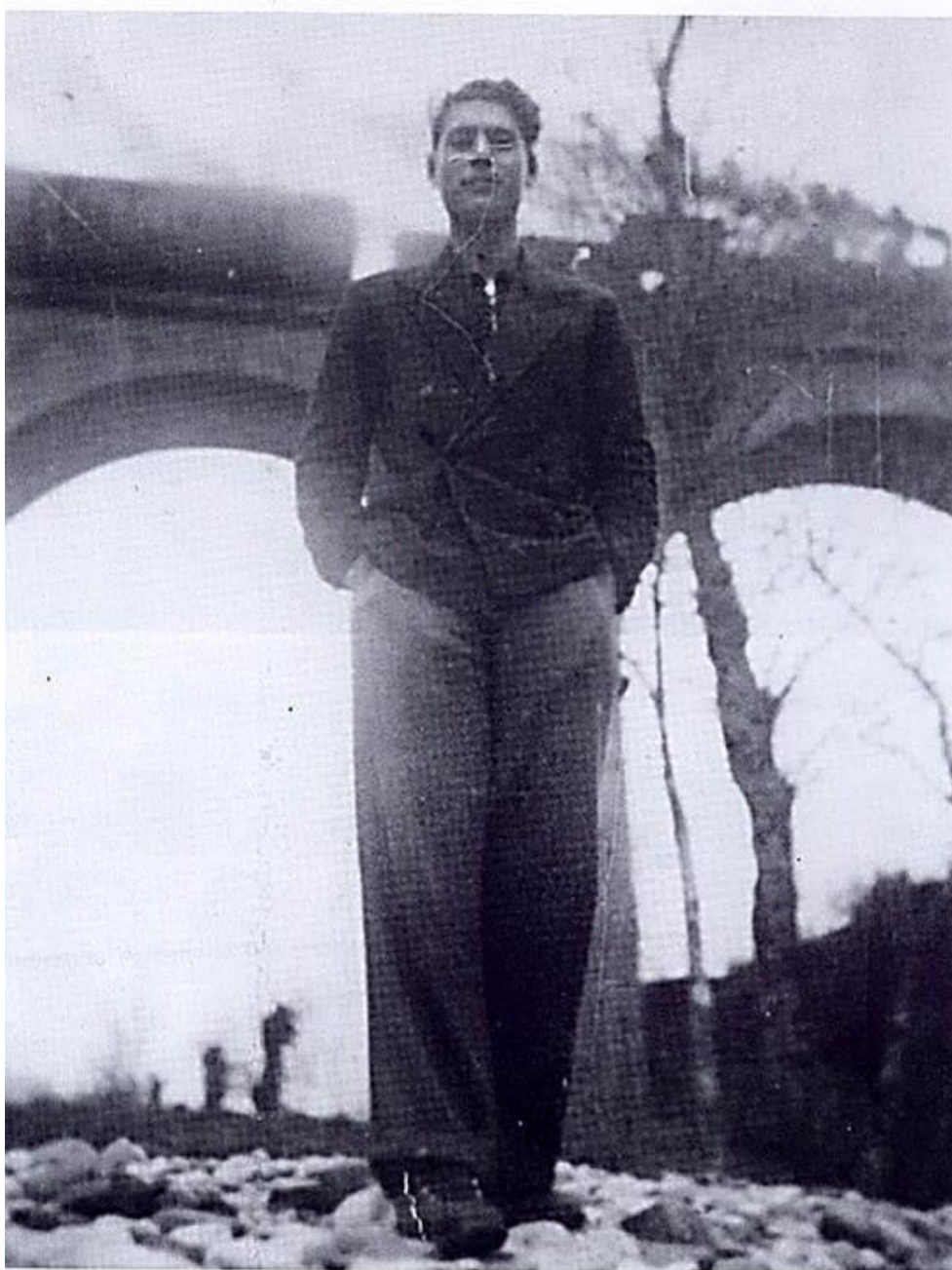
Viadotto Ponte della Simonetta: 1° ponte sul Cinisco con treno merci nella direzione Urbino-Fabriano.
