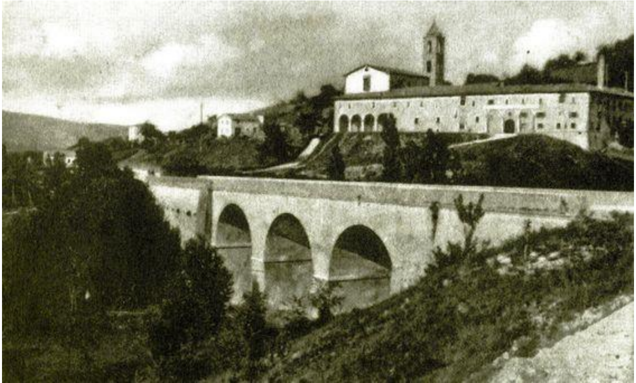
Pergola Ponte dei Giardini
