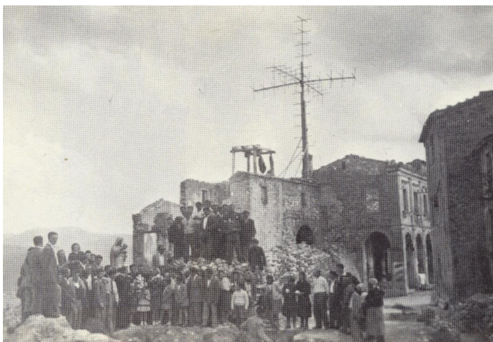
Chiesa di S. Donato distrutta
